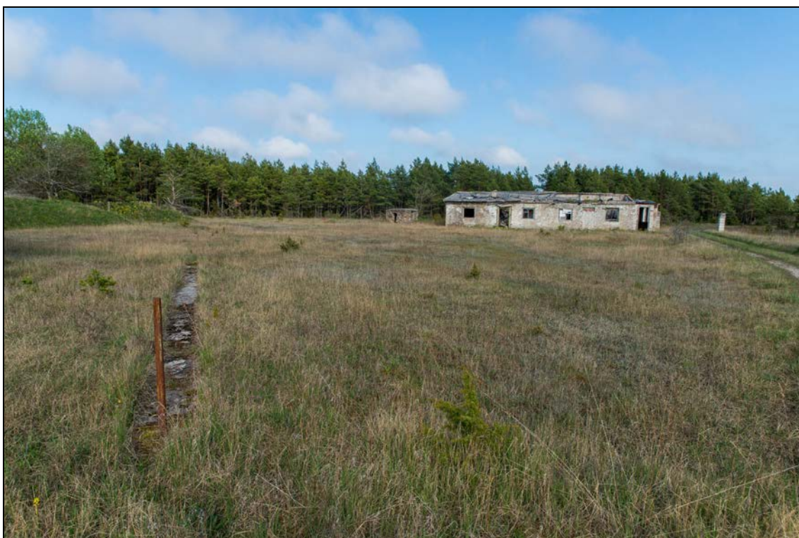
Foto 94 (318). Tammese (Kõruse) raketibaas. Betoonaärisega plats [23], taga paistab pääsla [19]. Foto Mart Mõniste 19.05.2014
