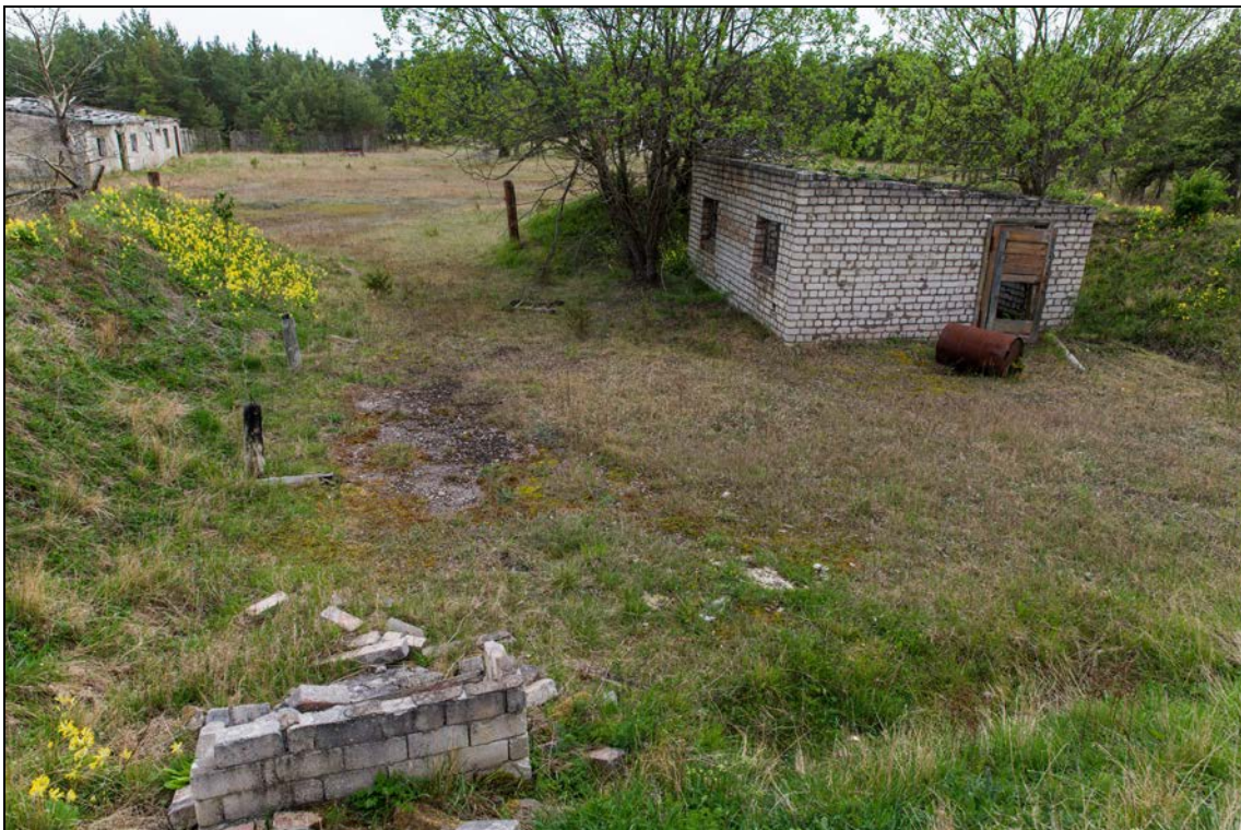
Foto 84 (277). Tammese (Kõruse) raketibaas. Kütuseladu [21].
