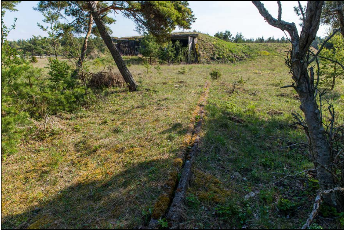
Foto 15 (086). Tammese (Kõruse) raketibaas. Komandokeskusest [1] suunduvad kaablikanalid stardipositsioonidele.
