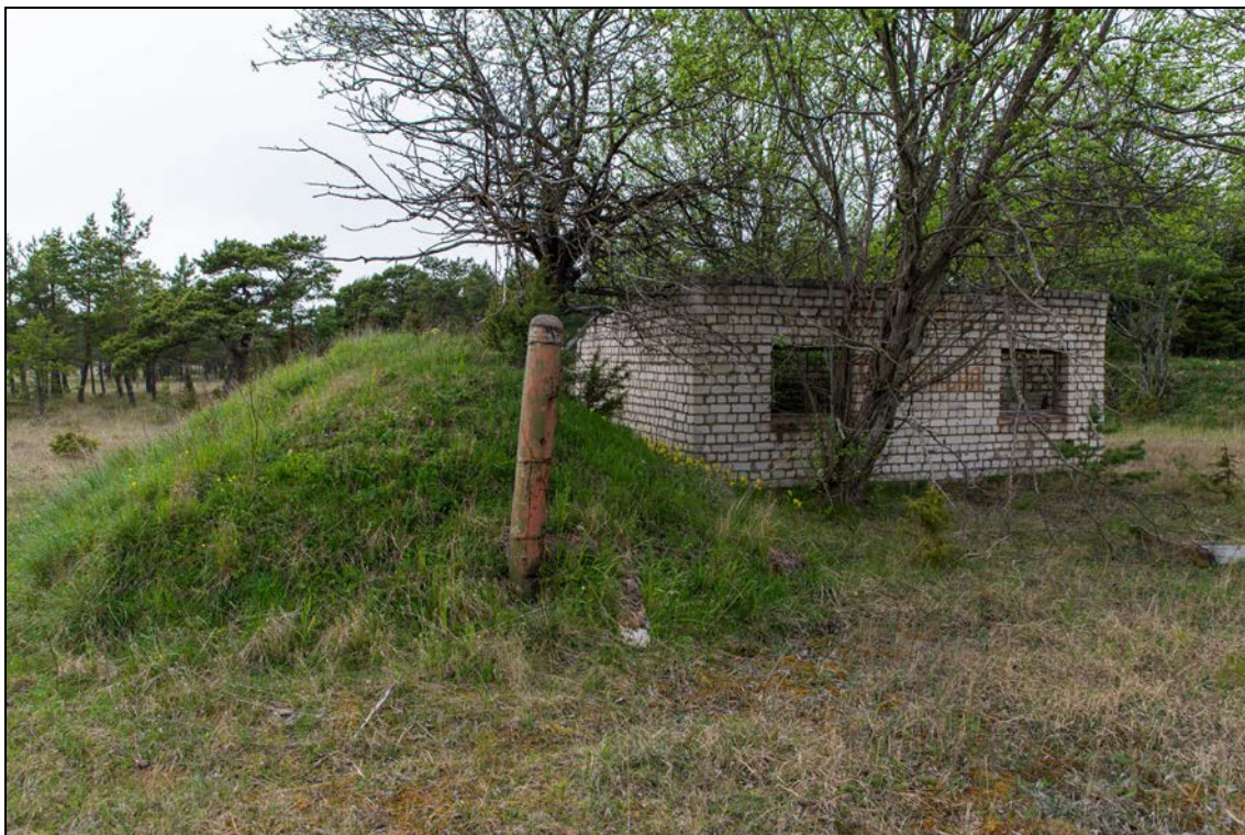
Foto 85 (275). Tammese (Kõruse) raketibaas. Kütuseladu [21]. Foto Mart Mõniste 19.05.2014
