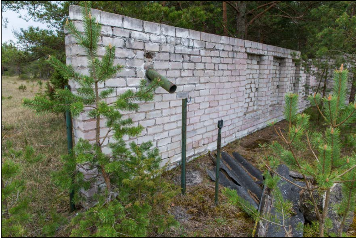
Foto 69 (230). Tammese (Kõruse) raketibaas. Vahtkonnalinnak [18]. Esiplaanil relvakontrolli koht.
