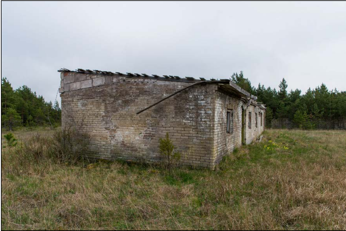
Foto 79 (257). Tammese (Kõruse) raketibaas. Pääsla [19]. Ümberehituse käigus on viilkatuse asemel tehtud lamekatust.
