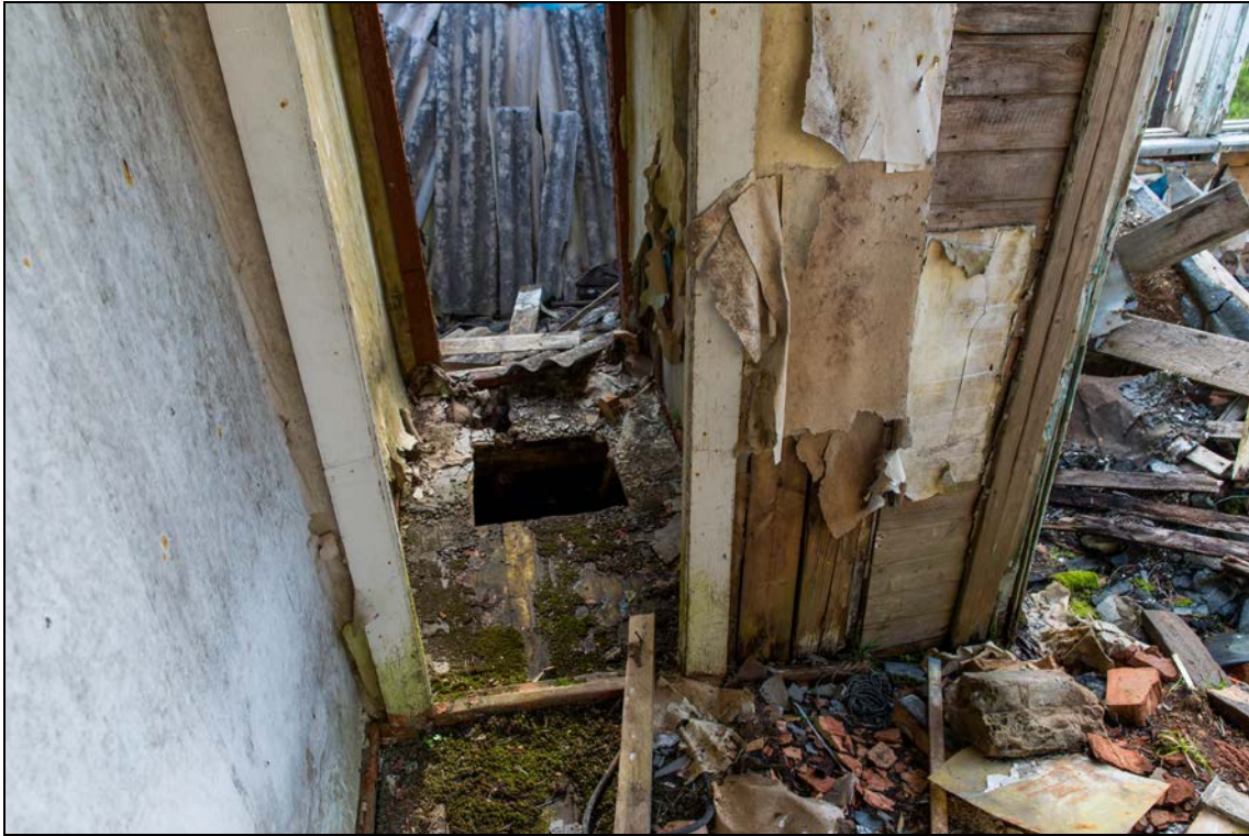
Foto 111 (393). Tammese (Kõruse) raketibaas. Elamu [28] esikupõrandas on keldriluuk. Foto Mart Mõniste 19.05.2014
