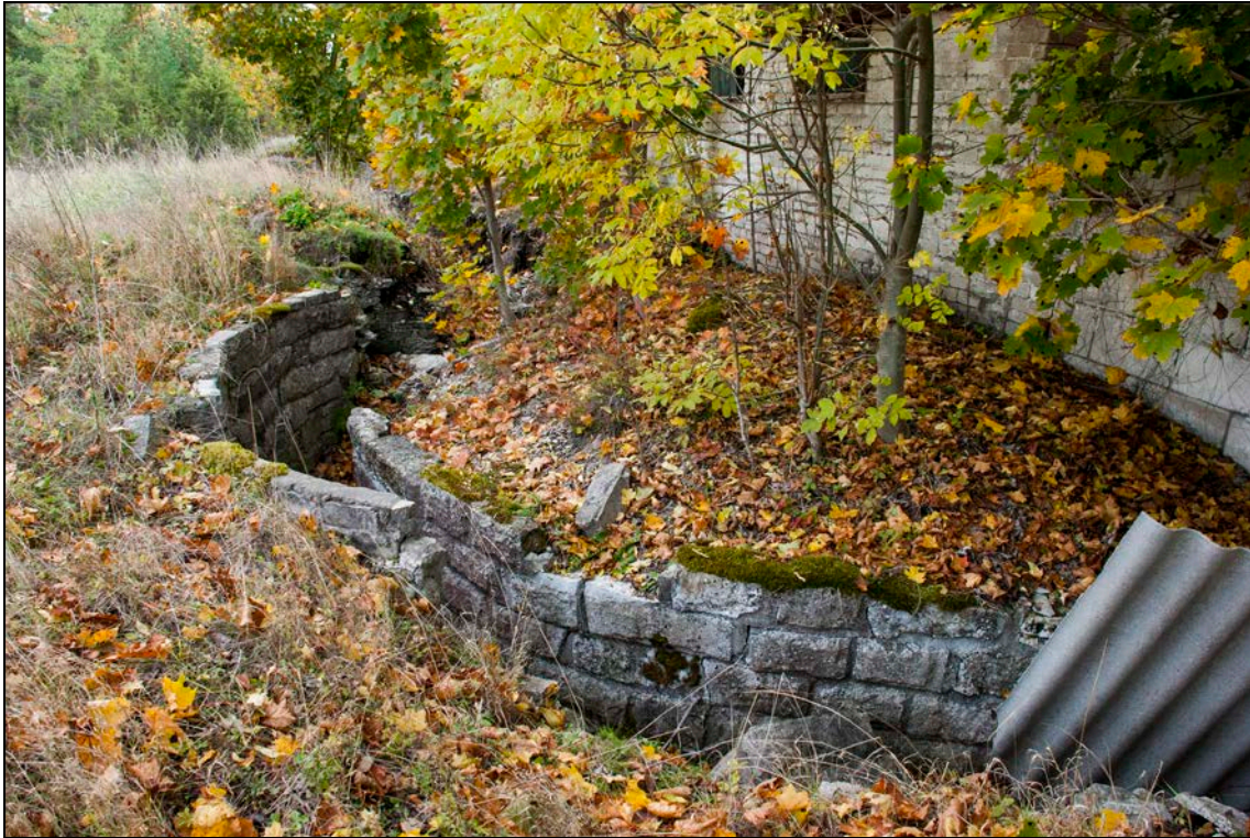
Foto 15. Kõruse kordon. Dolomiidiga vooderdatud kaitsekraav [12] garaaži [2] taga. Foto Mart Mõniste 29.09.2013.
